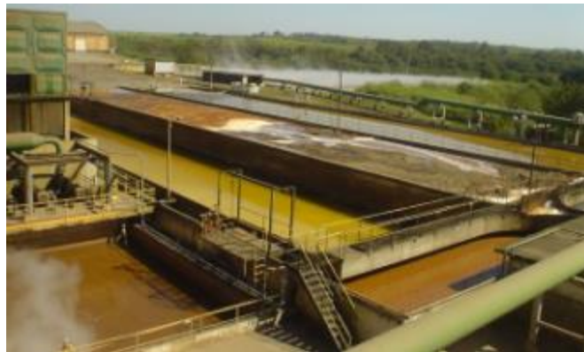
Fig. 3. Estação de tratamento de água. Foto: Rogério Haruo Sakai.
